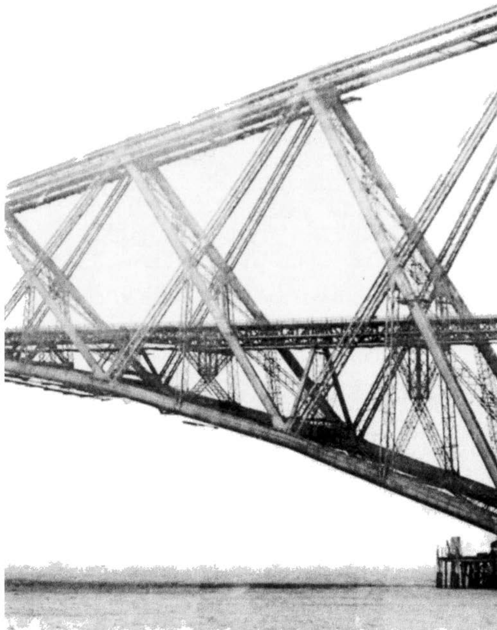
لا أهمية للمناقشات الجمالية: جون فولر، بنيامين بيكر، جسر السكة الحديدية الرابع، إنشاء الحامل المركزي، أيلول 1889
