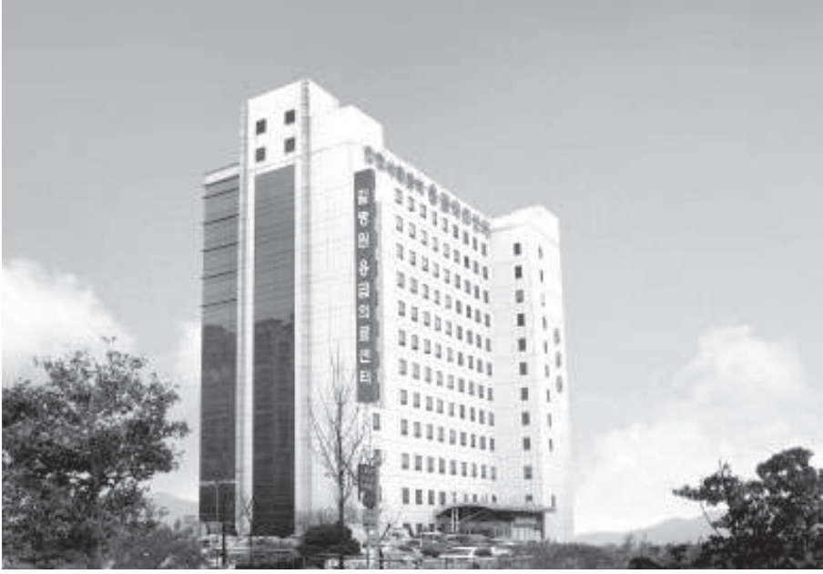
المركز الطبي للطوارئ التابع لـ"مستشفى غيل"
