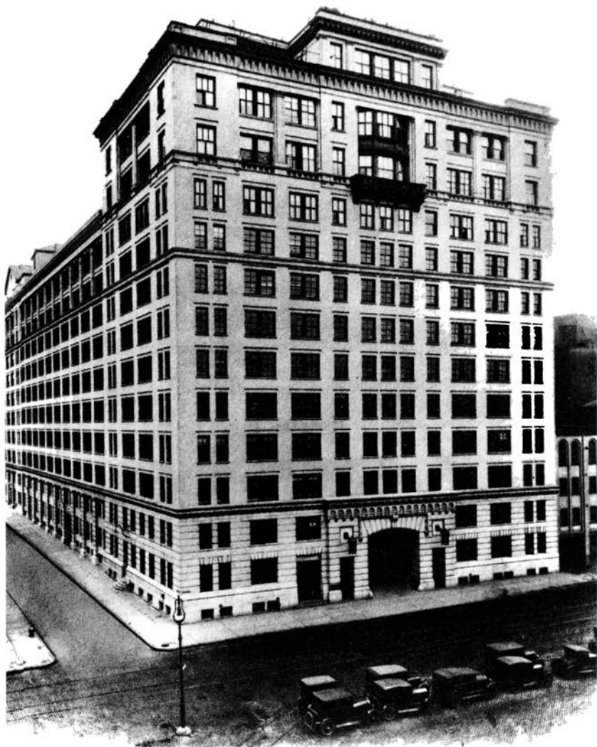
صورة 11: مبنى مانهاتن حيث عمل ماريسون وابتكرو ساعته الكوارتز في الطابق السابع، يقع هذا المبنى في 463 ويست ستريت، المقر السابق لمختبرات بيل.
