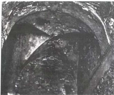
شكل (٣-١٩) صورة التقطتها «بيل» لبقو متقاطع بركن الدهليز 28 الشمالي الشرقي، حيث لا يزال الجص سليماً. هذه الأمثلة من الأقبية المتقاطعة نادرة في الأخضر. ولا تظهر إلا في ثمانية نماذج بالقصر والملحق الشرقي المجاور.
