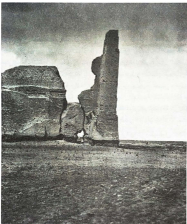
شكل (٤-٨) صورة التفككتها «بيل» للجزء الخارجي من طاق كسرى من ناحية الجنوب، وتكشف الميل إلى الأمام الذي أصاب الواجهة الجنوبية، ومداميك الطوب المتآكلة في الأساس. ورغم المساعي المختلفة لإصلاح وترميم الصرح المستمرة إلى يومنا هذا، واصل الطاق التدهور بمدلٍ مُخيف.
