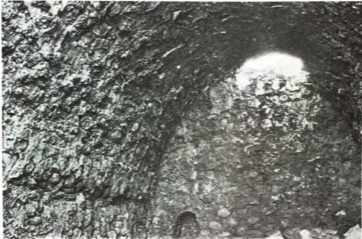
شكل (٥-١٢) الغرفة رقم 31 في «شاهل قابو»، ونرى قُبواً بيضياً قطعاً، ومحرجاً موقوفاً بالجدار الخلفي. قارنت «بيل» بين الأقبية الموجودة في «قصر شيرين» وتلك الموجودة في «الأخضر»، رغم اختلاف مواد البناء التي أُستُخدمت في الحالتين (حجارة مقبل قوالب طوب).
