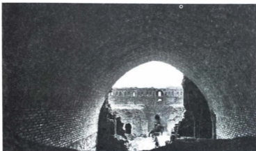
شكل (٣-١٦) صورة التقطتها «بيل» للقبو الجملوني المبنى بالطوب الذي يغطي القاعة الكبرى في قصر الأخيضر، من الجهة المطلّة على الناحية الجنوبية حيث «ساحة الشرف»، التي نصبت فيها «بيل» خيامها أثناء زيارتها للموقع في العام 1911.
