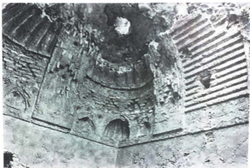
شكل (٣-١٤) الركن الجنوبي الشرقي من رواق المسجد الجنوبي المسقوف (رقم 11) الذي كان يحظى بأحد أجمل الأقبية في القصر. ويضم ربع قبة شكلتها أقواس مستعرضة كانت مزخرفة بنمط جصّي مُحزّز وفتحات على شكل مُعينات ودوائر غائرة وحنبة ركنية محززة وأشباه قباب جانبية قليلة العمق.
