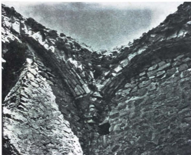
شكل (٣-١٨) صورة التقطتها «بيل» لبقايا قبو متقاطع يوجد في الركن الشمالي الغربي بالغرفة 141 في الملحق الشرقي. لا تزال الخاصرتين المائلتين كما هما، رغم تهبأر باقي القبو المتقاطع.
