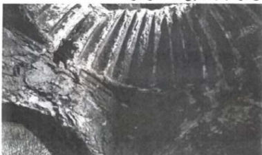
شكل (٣-٢٠) صورة للتظننها «بيل» للركن الجنوبي الغربي بالقبة المحززة في الغرفة رقم 4. ربما كانت القبة مزودة في الأساس بفتحة في فمتها. يُمكننا أن نرى الطريقة البدائية التي أُقيمت بها القبة فوق دعائم في أركان الحجر المربعة، بدلًا من الحنايا الركنية أو لمعلقت الركنية التي تلت تحول زوايا الغرفة إلى منحنيات لقبة بشكل أكثر كفاءة.
