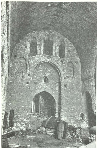
شكل (٧-٣) صورة التغطتها «بيل» للقاعة الكبرى (رقم 7)، بمواجهة الجانب الشمالي، بمدخلها المقوس المنحني في المنتصف والذي يؤدي إلى البوابة الرئيسية. في الأعلى مباشرة شبه قبة مُحاطة بمحارابين. وفي أعلاهما ثلاث نوافذ تزود الغرفة رقم 88 التي تقع بالطابق الثاني من القصر، بالضوء.
