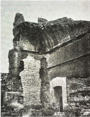
شكل (٣-٥) صورة التقطتها «بيل» لأحد أركان قاعة «هوريك بيرس» في «فيلا هاربان» بتفولبي (إيطاليا). ربما لم تستلهم «بيل» مسعاها لتصوير هذا المعنى من اهتمامها بالبناء بالطوب، بل من اهتمامت «خان ديمان»؛ رفيقتها في السفر التي لفتت قنباها إلى أسلوب البناء لشبيهه بالشبكة المعروف باسم «opus reticulatum»، وإلى أطواق الطوب الأقفية والرأسية حول المنخل.
