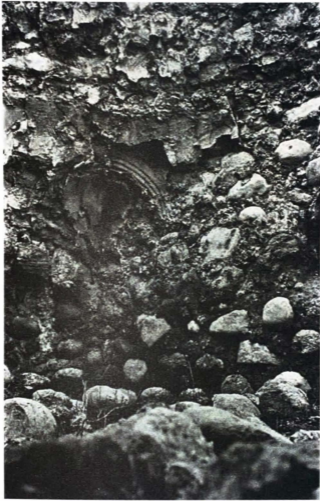
شكل (٥-١٢) تمكّنت «بيل» من العثور على معالم أثرية مشيرة بين نقائص «مشاهر قايو»، مثل هذه الحنية الركنية بالغرفة رقم 14 التي كتلت تساعد في حلحلة الزاوية الموجودة بين التصميم المربع للغرفة بالأسفل، وبين سقفها المقيب. ولا تزال أجزاء من الخزرف الشرطية الجصية سليمة.
