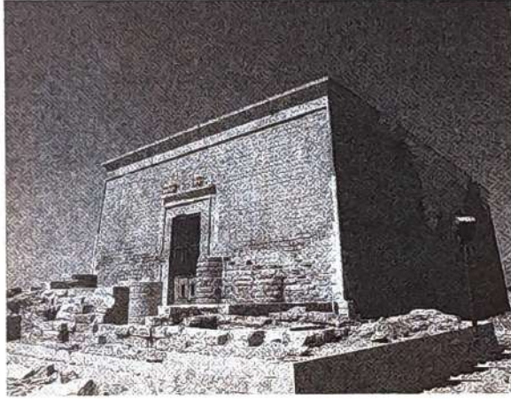
قصر قارون بعد ترميمه
