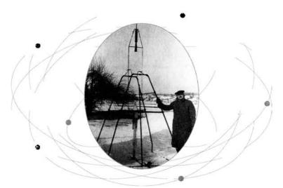
الخط الزمني: 1908: يدرس كودارد الفيزياء في جامعة كلارك. 1915: يعرض كيف ان محركات الصواريخ تولد قوة دفع هائلة عند تفريغ الهواء. 1926: يطلق أول صاروخ يعمل على الوقود السائل ويرتفع بمقدار 15 مترا. 1930: يبدأ العمل في روزويل في نيو مكسيكو حَيثُ لينتج صواريخ اسرع من الصوت ومتعددة المراحل وممكن التحكم بجنيحاتها.
