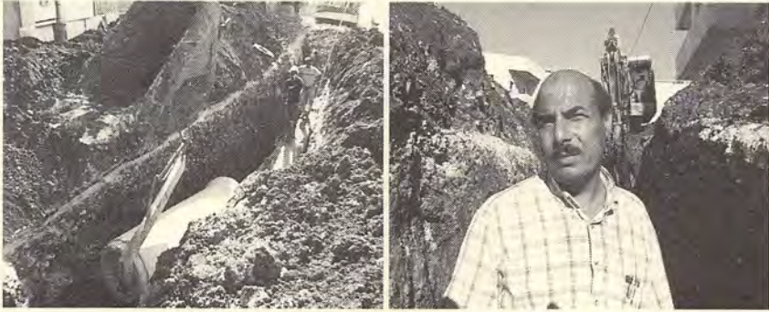
الصورة اليسرى: أعمال البناء في مخيم جنين للاجئين. الصورة اليمنى: المهندس أحمد أبيضاري من الأوتروا.
